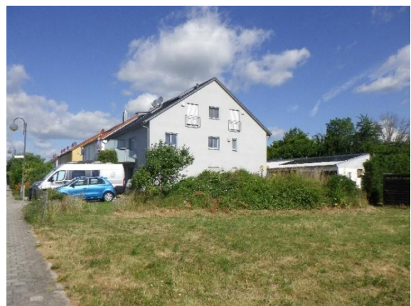
Abb. 13. Bebauung nördlich Straße „Lehenbuckl“
