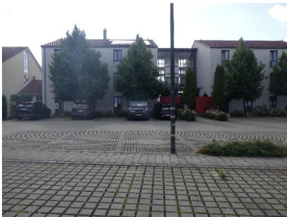
Abb. 11. Gewerblich genutzte Gebäude entlang der Nürnberger Straße
