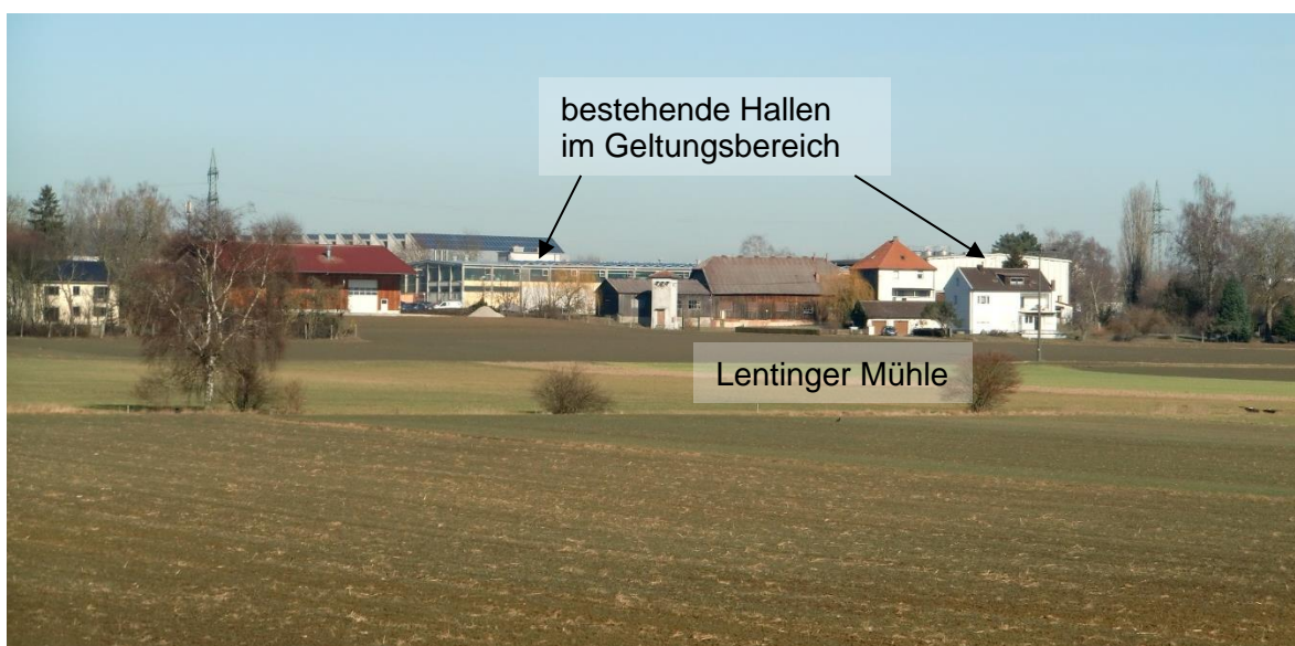
Abb. 1. Blick von Süden auf den Vorhabenstandort mit Lentinger Mühle im Vordergrund
