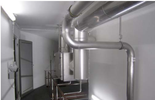
Neue Lüftungsanlagen für die beiden Wasserkammern sowie für die Technikräume gehören zum Sanierungsumfang für den Lentinger Hochbehälter. Nach rund einem Jahr Bauzeit konnten diese Sanierungsmaßnahmen im Juli dieses Jahres abgeschlossen werden.
